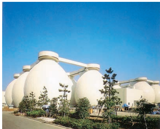
写真-3 横浜市北部汚泥処理センター
