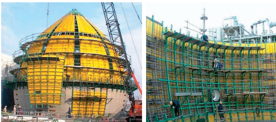
写真-2 RSB 型枠
