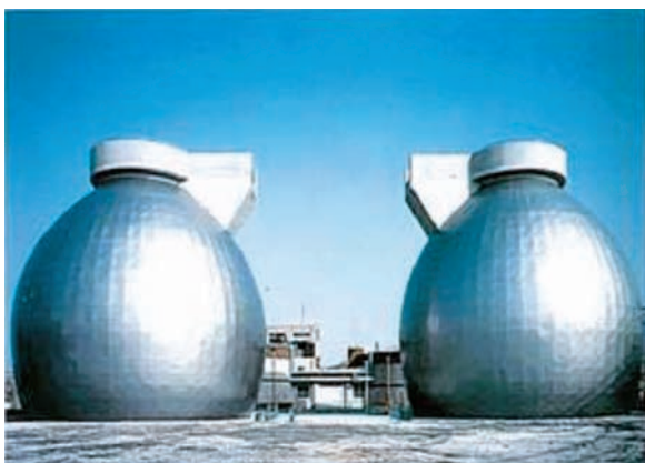
写真-1 北九州市皇后崎処理場卵形消化タンク
