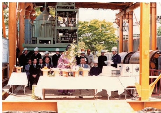
写真-4.7 所内試験でのシールド機発進式(右端は司会の鶴田)
