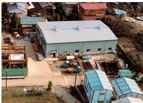
写真-4.1 ライニング実験棟及び周辺中央右には立坑が見える
