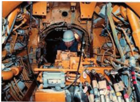
写真-4.4 システムダウンを起こし、天井部設置の固まった混合打設機を降ろす。一度トラブルと1週間単位の日数と多大の金が吹っ飛んだ。
