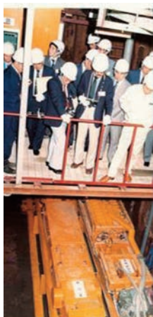
写真-4.11 掘進現場(立坑)に案内。記者達も実際の動きを見て理解。下方に見えるのは、無軌道材料運搬車
